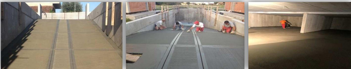
La pavimentazione della rampa autorimessa eseguita a spina di pesce in calcestruzzo al quarzo, pavimento area di manovra piano interrato e garage in calcestruzzo lisciata ad elicottero con finitura al quarzo.
