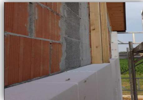
successivamente viene applicato uno strato di preparazione del fondo per l'applicazione finale dell'intonaco di finitura, colore a scelta della DD.LL. Chiodatura del pannello isolante con chiodi idonei e copri tassello dello stesso materiale isolante per eliminare ogni ponte termico.
